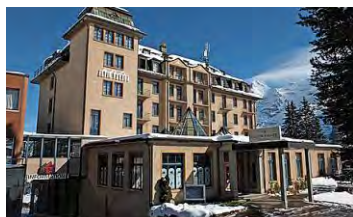
Das Hotel Palace soll durch eine sanfte Renovation neuen Aufwind bekommen. Foto: BOM
